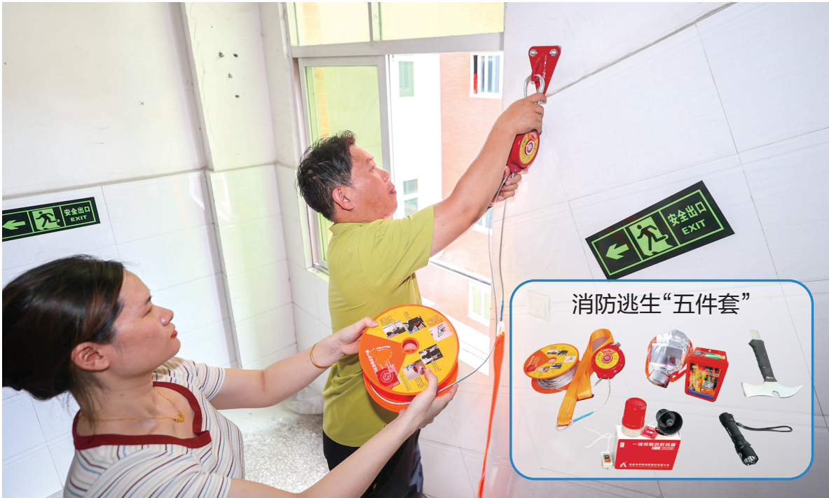
工作人员在安装自助应急装备(缓降绳索)。
