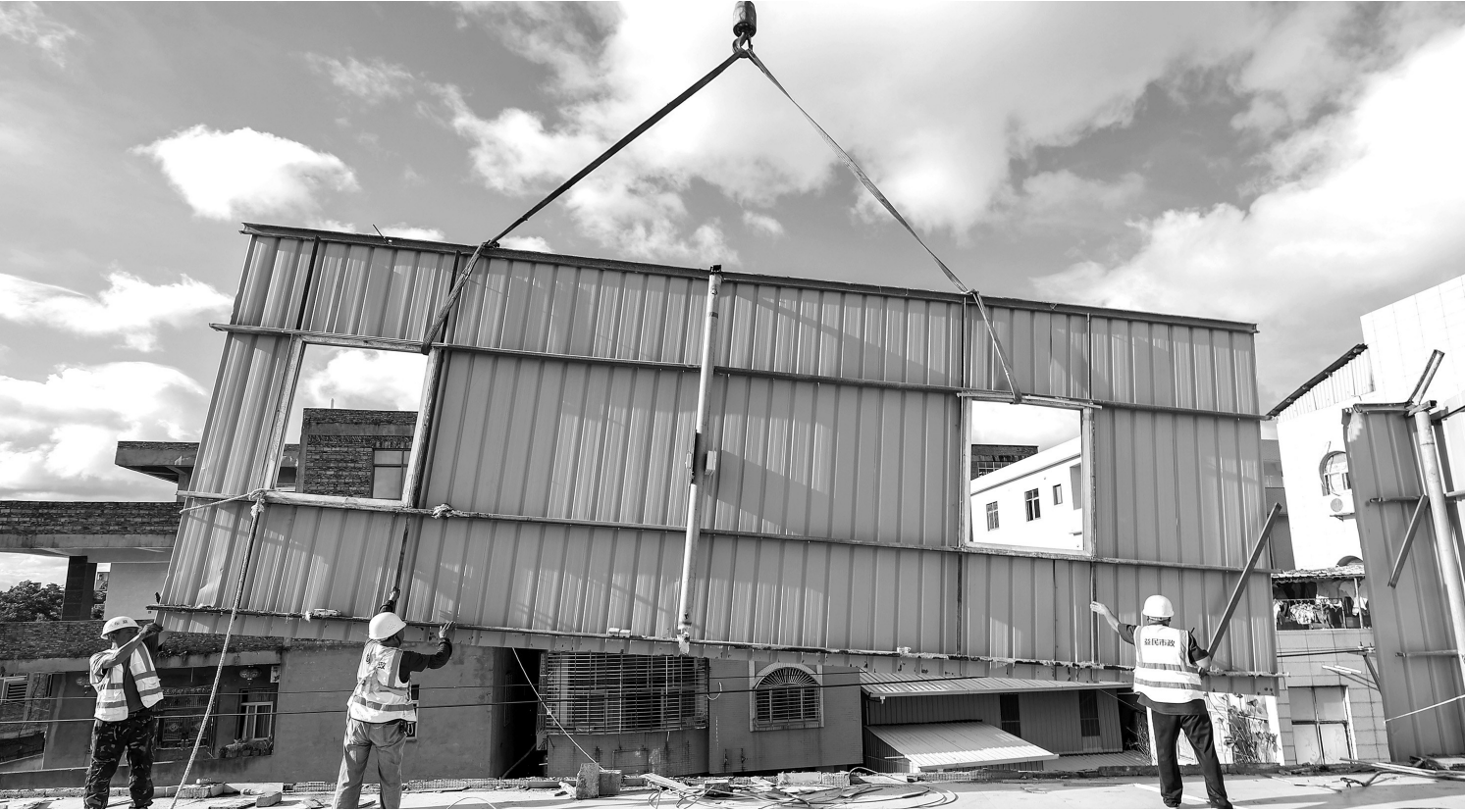
江头村衡翔体育用品有限公司厂区内,工人对用作仓库的铁皮搭盖进行拆除。
