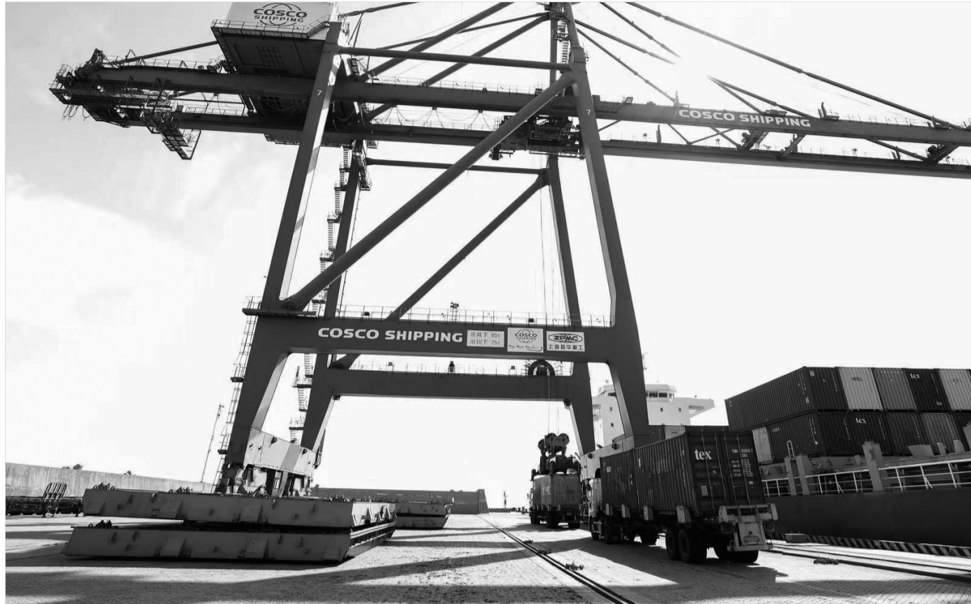
在晋江围头港码头,起重机进行吊装作业。 本报记者 陈巧玲 摄
