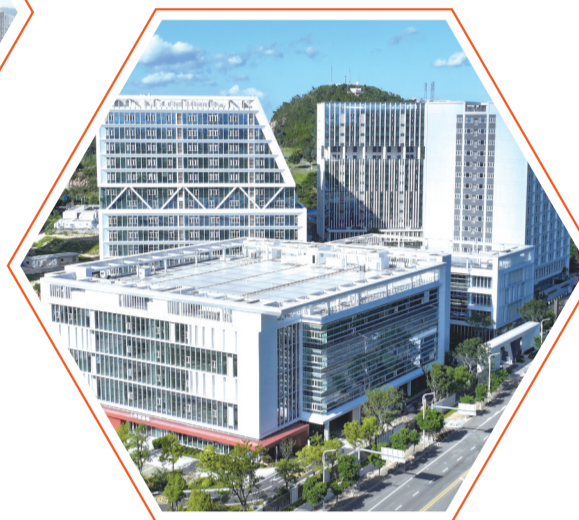
建投睿谷产业园
