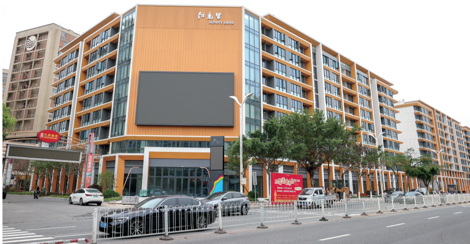
青阳街道阳光社区“阳光里”项目完成“自主更新”。
