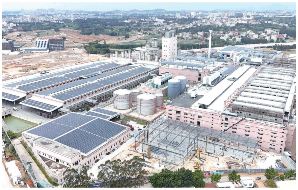
正在加紧建设的百宏纺织智造园十期项目
