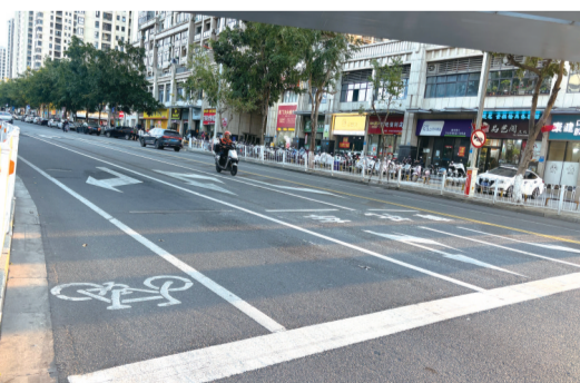
晋江梅园路万达广场C区附近灯控路口,原有的两车道增加为三车道。
