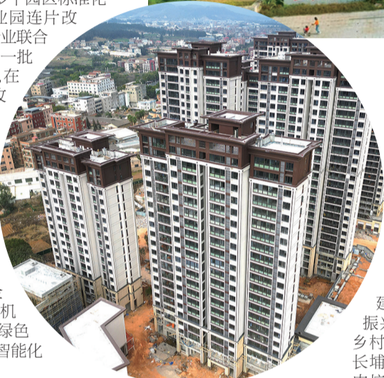
梨韵花园安置房项目全面封顶,预计今年10月竣工验收。
