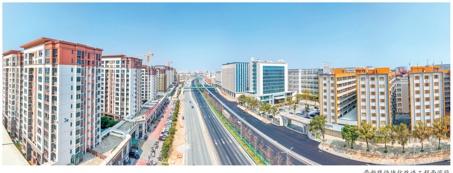
晋新路快捷化改造工程西滨段
