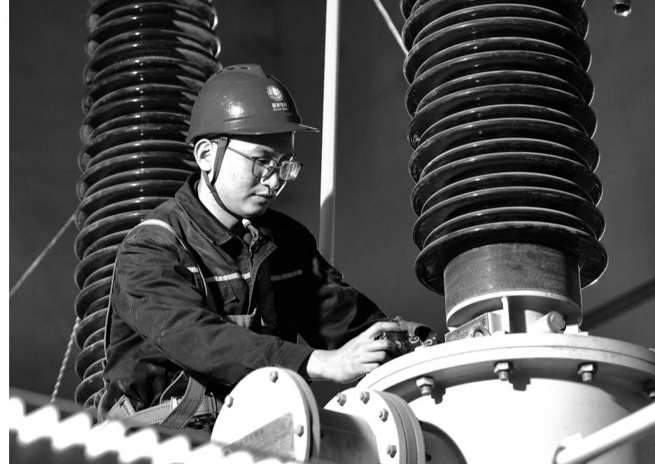
本报讯（通讯员 刘煌铭 林彬忻 记者 颜雅）为扎实提升电网供电可靠性，全力保障系统迎峰度冬，12月8日至20日，国网晋江市供电公司勠力攻坚，圆满完成110千伏龟山变电站年度检、主变保护改造、主变渗漏油缺陷处置等重要工作，精检细修，为电网安全运行注入“强心剂”。
