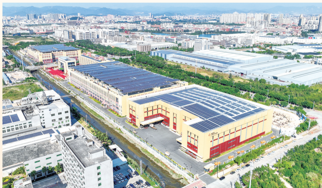
凤竹厂房屋顶铺设了4.7万平方米的光伏发电板，年均发电量约650万千瓦时。 本报记者 董军 摄
