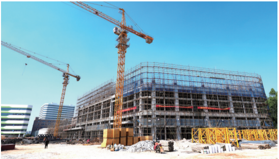
意融兴智造园项目施工现场一派热火朝天景象。
