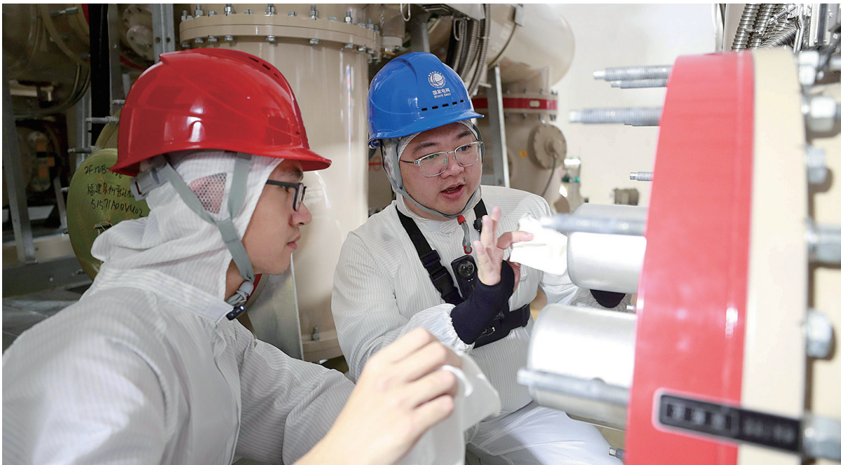
本报记者(右)体验电力工人高温下无尘作业。
