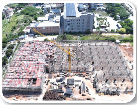
嘉维项目建设现场
