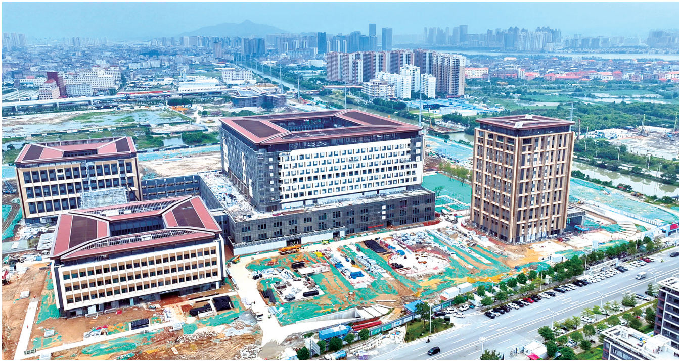
俯瞰上海六院福建医院和敏院区，整个项目尽显高端大气。 本报记者 秦越 摄
