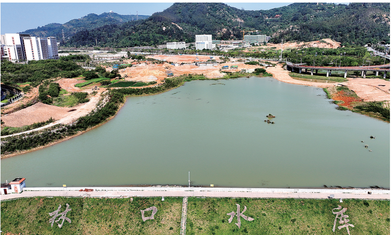
正在加紧建设的林口水库公园
