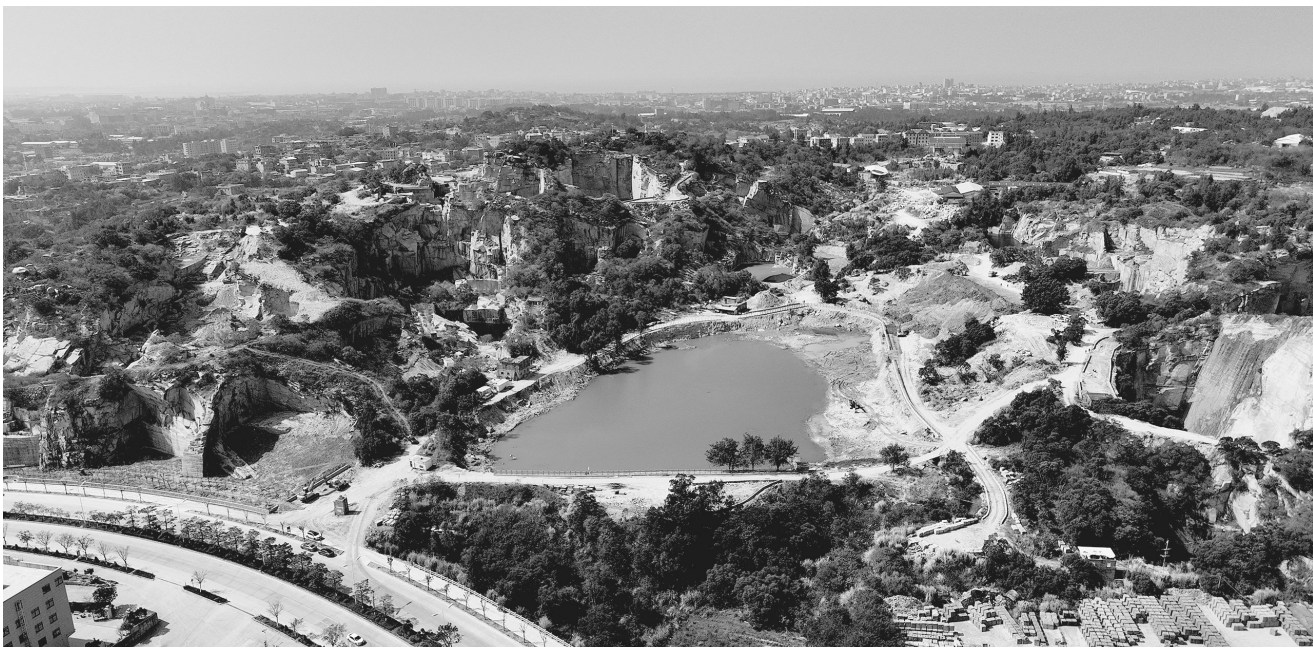
大覺山片區廢棄礦山生態修復項目航拍圖
