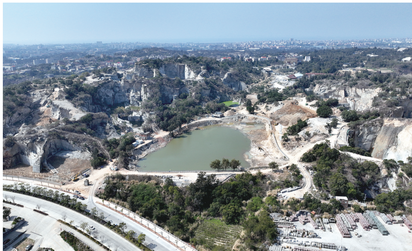
大觉山片区废弃矿山生态修复项目航拍图
