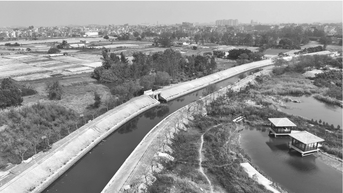
外曾溪横岸水闸至西沽港水闸景观提升工程进入收尾阶段。
