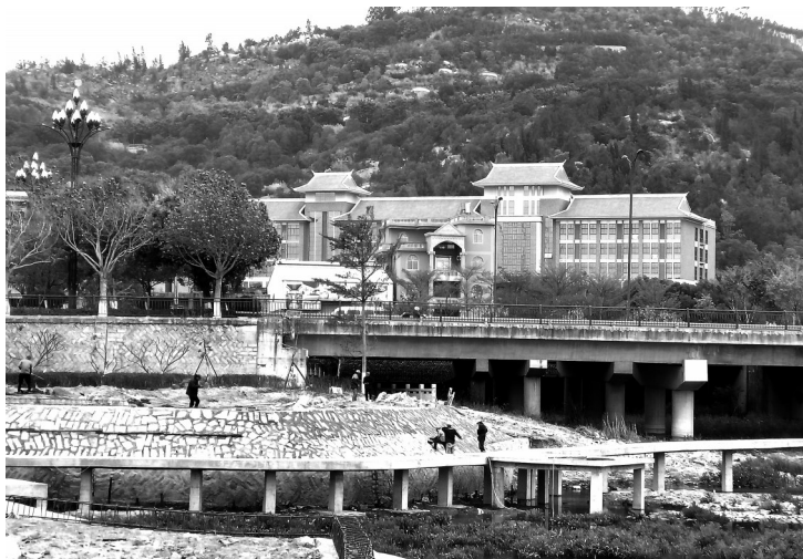
工人正在進行臨水護堤擋土牆及護欄施工。
