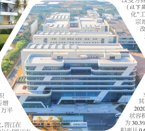
芯智造产业园
