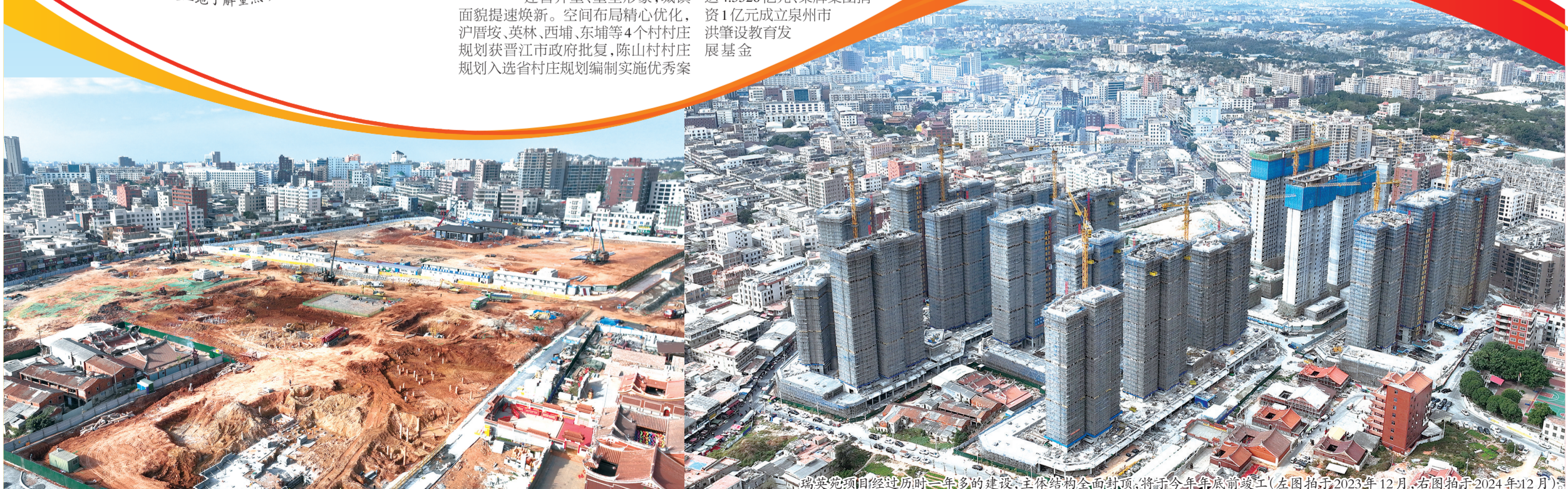
瑞苑项目经过历时一年多的建设，主体结构全面封顶，将于今年年底竣工（左图摄于2023年12月，右图摄于2024年12月）。
