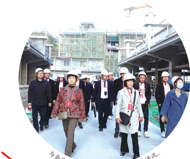
与会代表走进工地了解重点项目建设情况。
