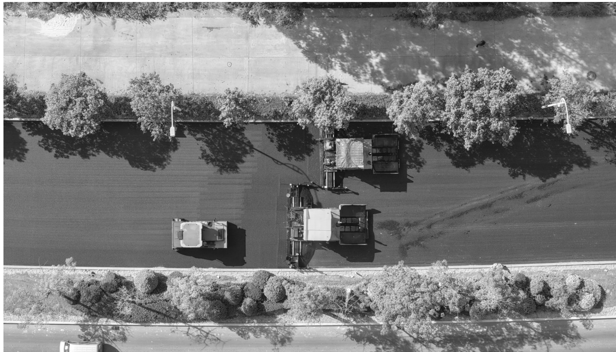
国道358线晋江段“白改黑”工程施工现场。
