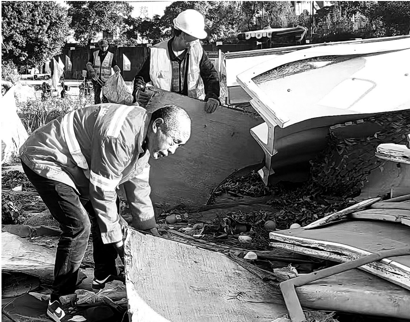
环卫工人清理建筑垃圾。
