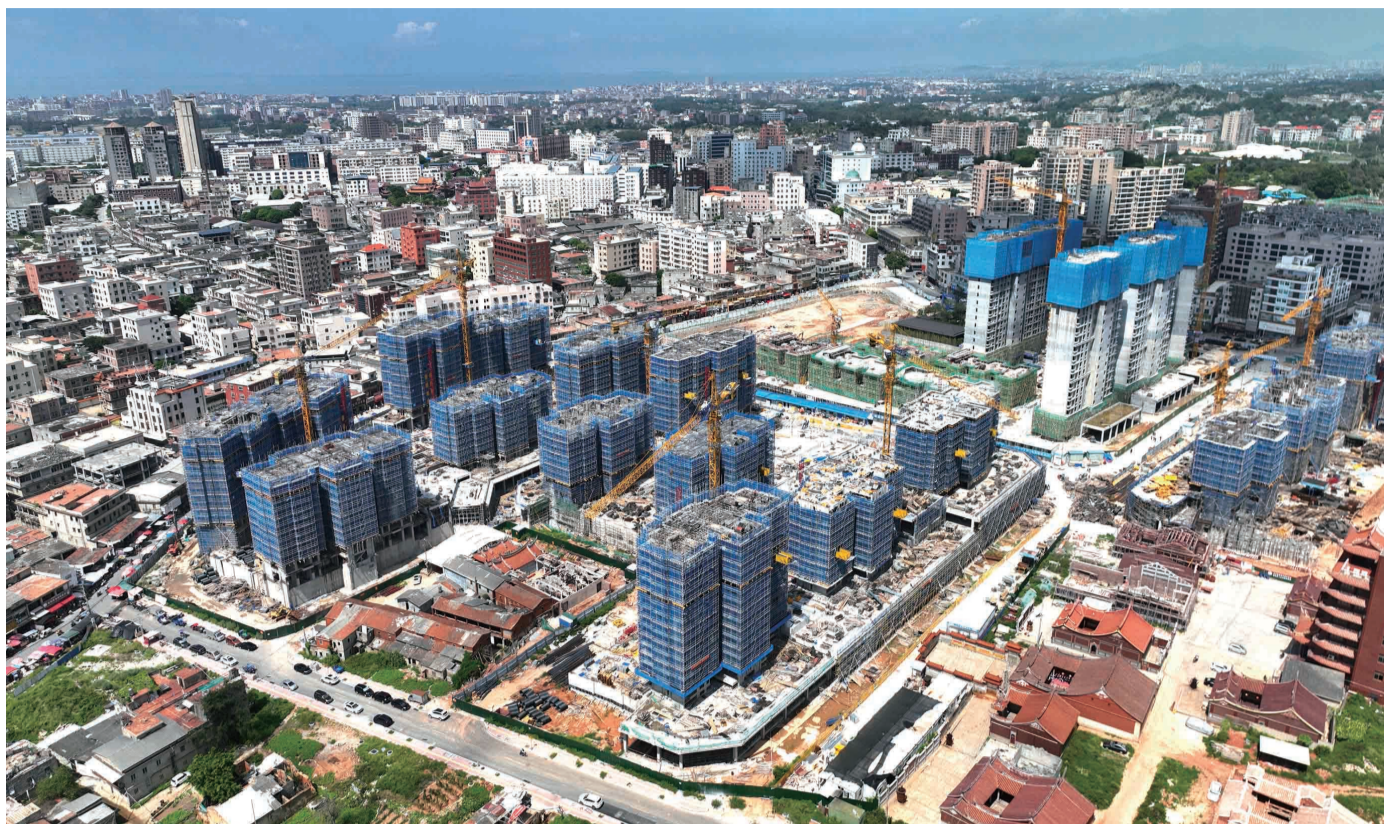
英林村旧村改造(一期)项目有序推进。
