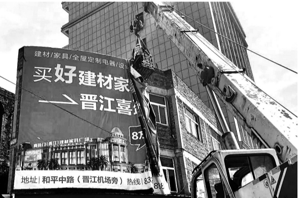
执法人员拆除影响逃生通道的广告牌。
