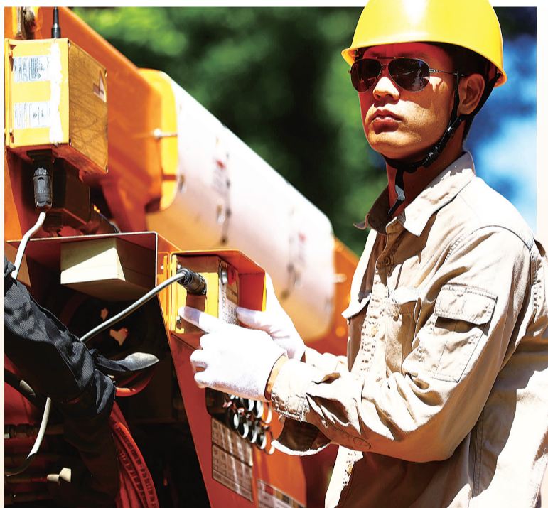
电力工人在烈日下操作电力作业设备。
