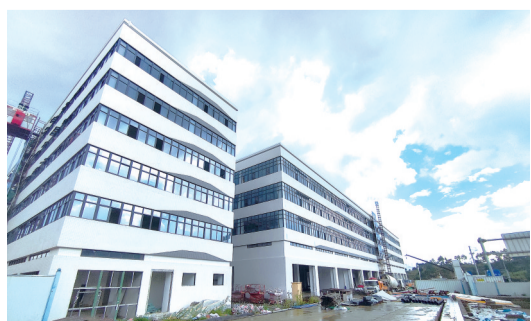
新天物流项目现场
