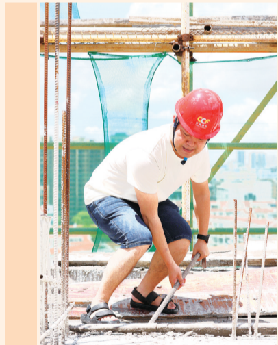
本报记者体验模板工人作业。
