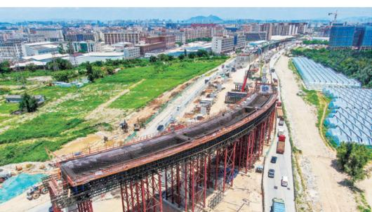
期天气晴朗，施工组加大人力物力投入，施工现场共有300多名工人、6套支架模板，全力抢抓时间推进工程建设，预计今年年底，可以基本完成现浇箱梁主体工程。
