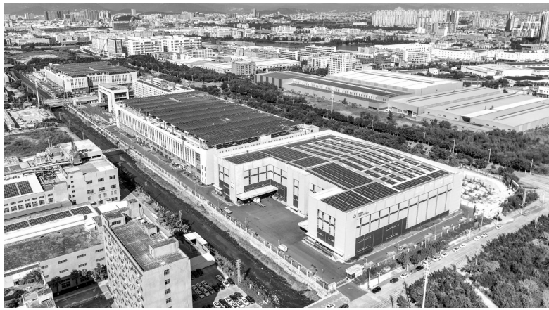
鳳竹紡織科技公司屋面覆蓋的太陽能光伏。
