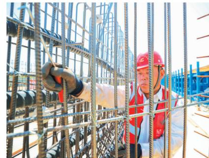
建筑工人正在绑扎钢筋。
