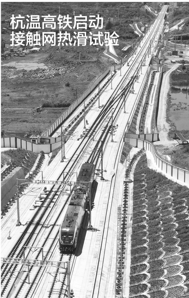
5月14日,首趟热滑试验列车行驶在杭温高铁横店站附近的线路上(无人机照片)。在接触网带电情况下,热滑试验列车以不超过80公里时速开展试验,通过受电弓的滑行,精确检测接触网与受电弓的弓网关系和受流网压等参数,确认相关设备设施达到联调联试条件。
