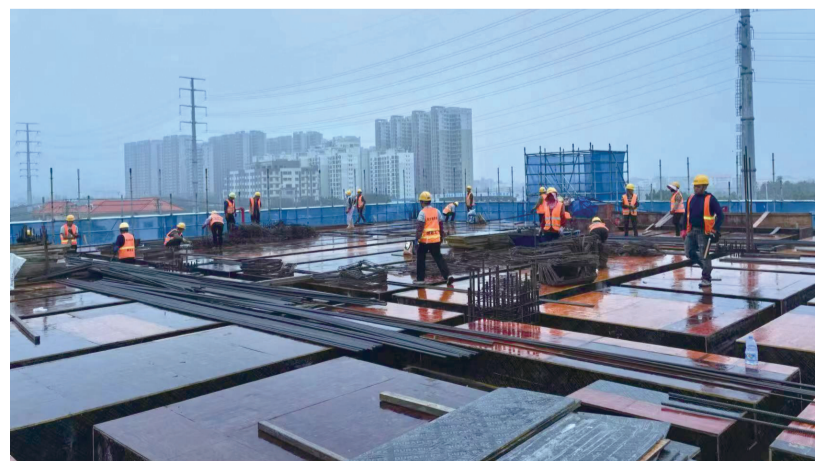
施工现场，工人雨中施工，抢抓工期。
