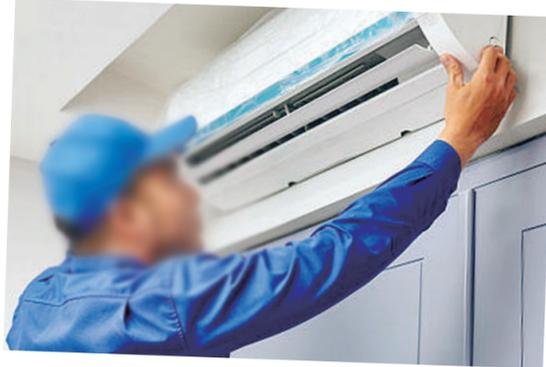
闭空调电源,确保安全。然后,拆下空调滤网,用清水冲洗干净并晾干。接着,使用专业的空调清洗剂或消毒液对空调内部进行喷洒和擦拭,注意避免液体进入电路。最后,将滤网重新安装好,开启空调通风模式,让空调内部干燥。清洗空调什么时机最合适?
