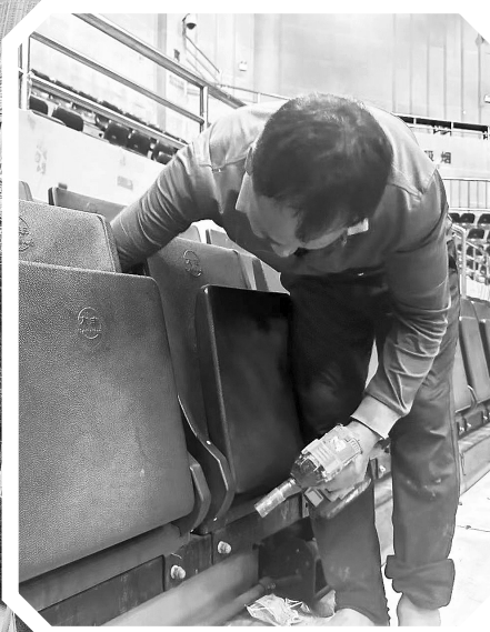
工人拆除舊座椅。
