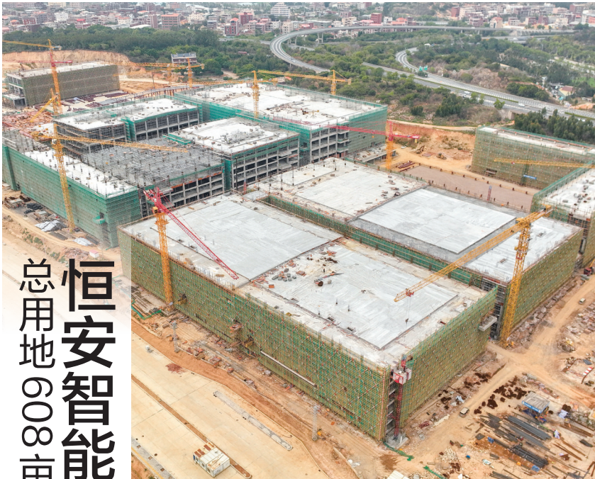
恒安智能化生产基地二期项目施工有序进行。
