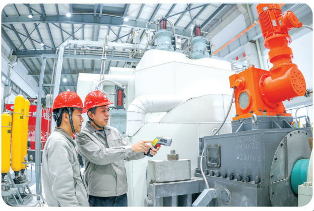
▲工作人员在给机组发动机测温。
