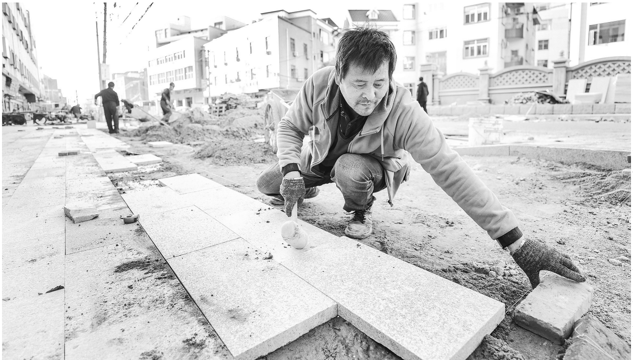
龙池路改造工程现场,工人正在铺设人行道。
