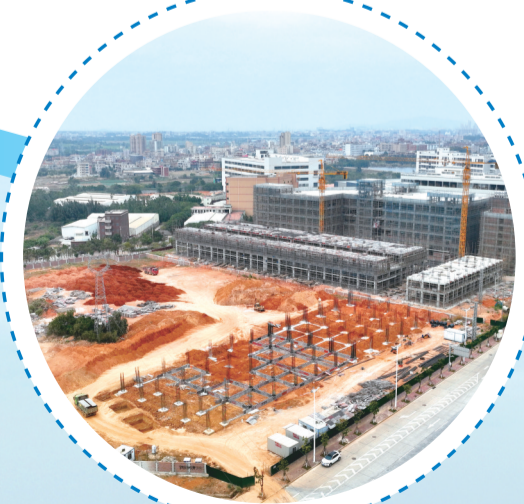
龙湖镇在建项目施工现场
