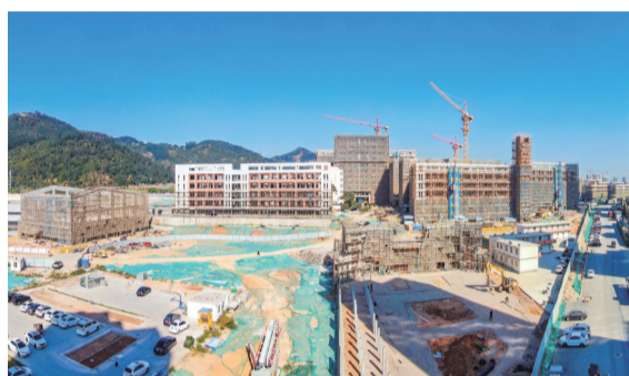
紫华中学改扩建项目建设如火如荼地推进。
