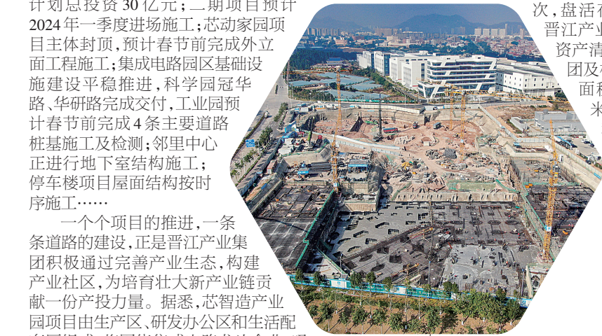
邻里中心项目
