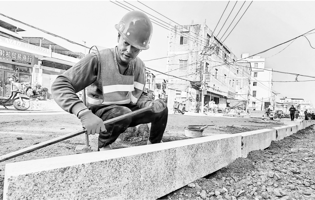
龙池路改造三期施工现场。
