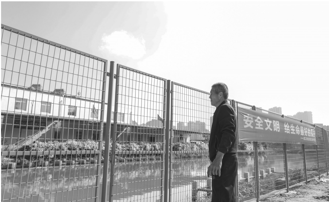
池店镇御辇村南低干渠边加装护栏网，消除安全隐患。
