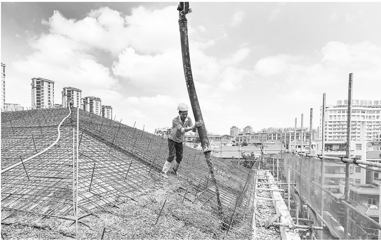
工人在屋面浇筑混凝土。
