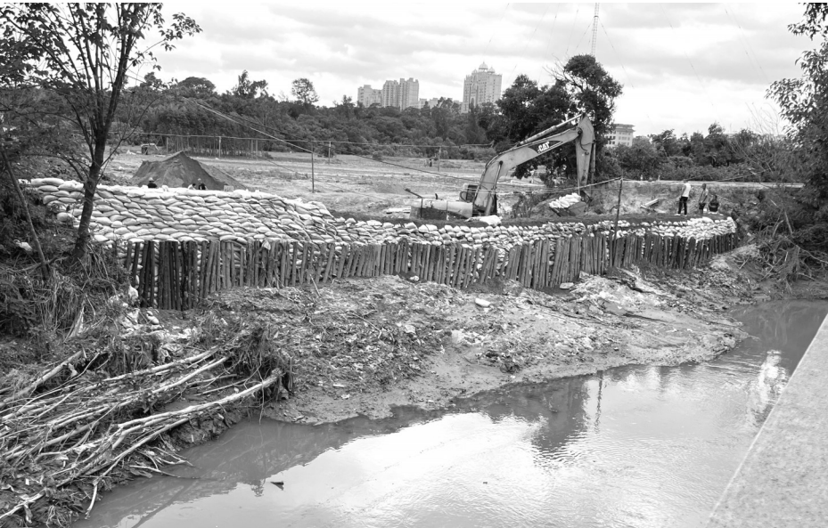
为防御台风,安海对河道进行加固。
