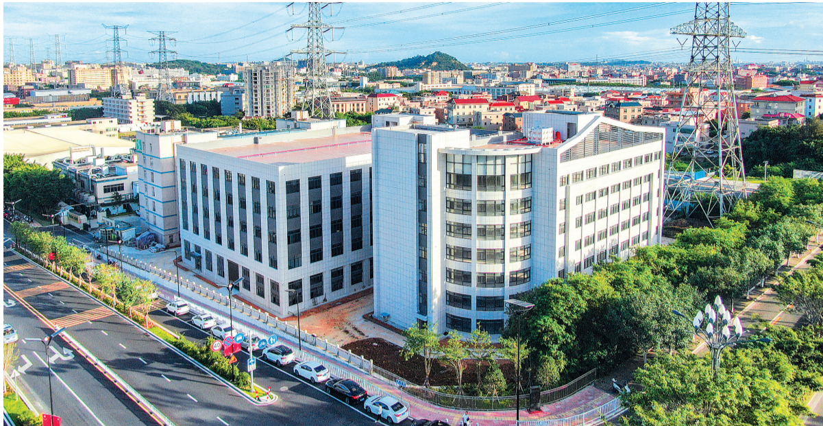
本次共有47个项目竣工,图为华清电子材料粉体国产化项目厂区。 本报记者 陈巧玲 摄
