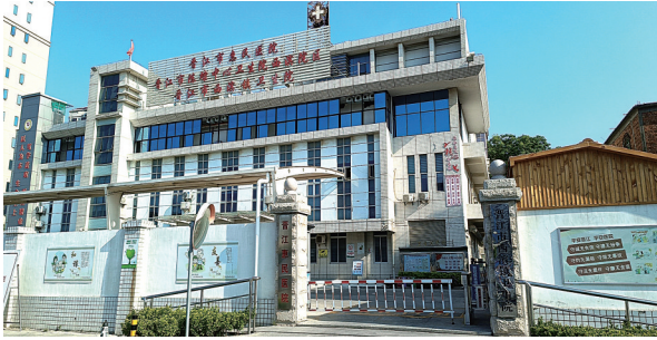
晋江市陈埭中心卫生院西滨院区
