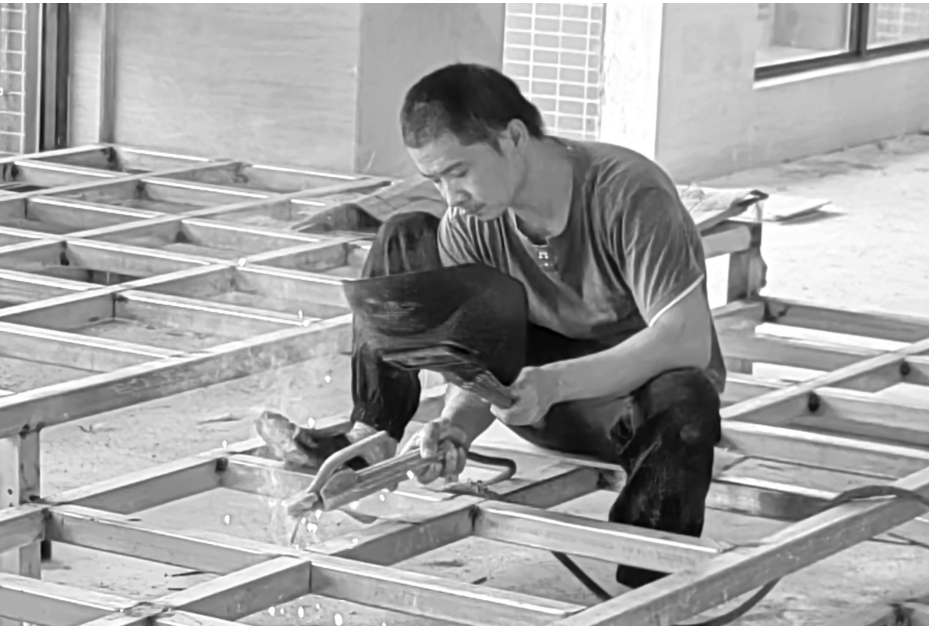
工人正在进行电焊作业。
