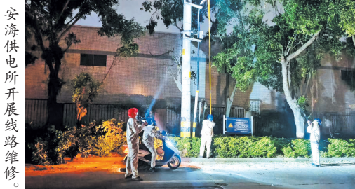
安海供电所开展线路维修。
