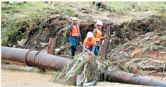
安平供水公司抢修破损原水管。
