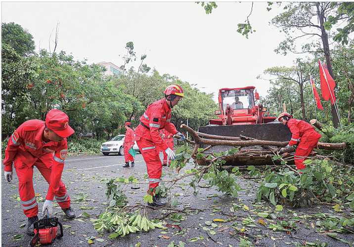
从厦门赶来支援的中国安能专业救援队队员，全力清理路面倒伏的绿化树。 本报记者 陈巧玲 摄
